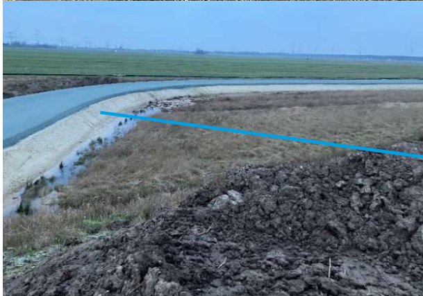
Baustrasse zur Erschließung Tunnelbau
